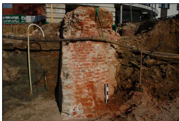
FIG. 30 Profiel B: de funderingsmuur van de burcht is duidelijk onderaan breder opgebouwd.
