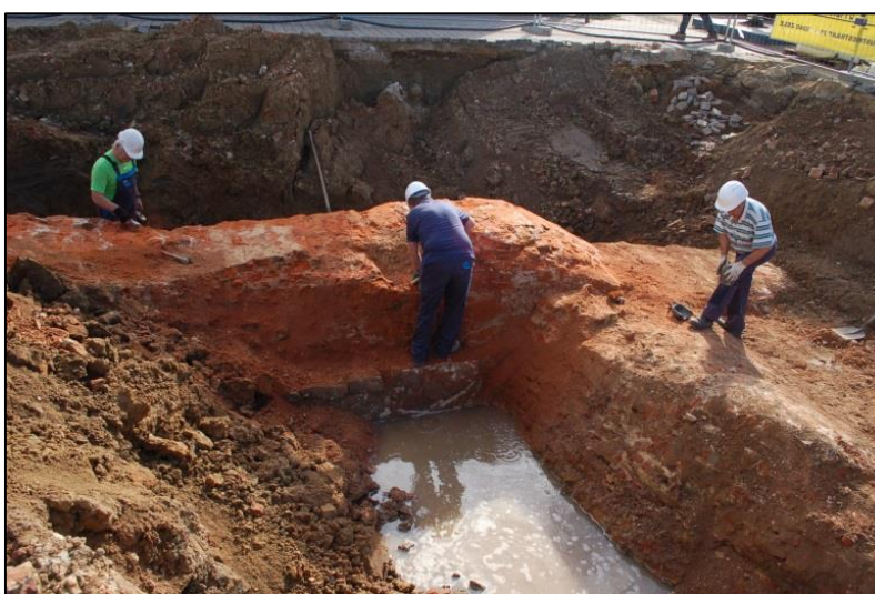
FIG. 19 De werkomstandigheden op het terrein tijdens het opschonen van de muur.
