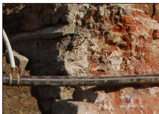
FIG. 28 De kraagstenen in kalksteen.
