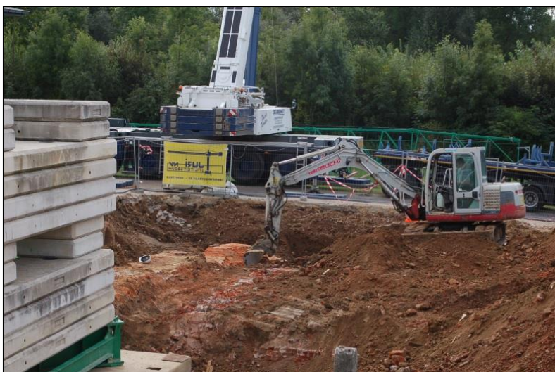
FIG. 18 Het vrijleggen van de bakstenen muur.
